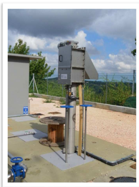
Figure 19 : Représentation d'un dégrilleur automatique vertical
